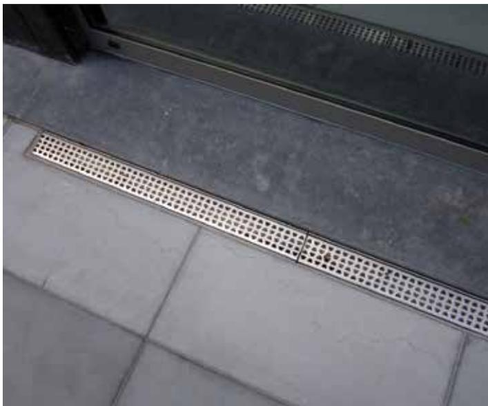
TROBA-LINE se compose d'une partie inférieure en U perforée et d'une partie supérieure et se monte au-dessus de la membrane de drainage TROBA-PLUS 8. L'eau passe par les ouvertures du caniveau de drainage, circule sur la natte de drainage et se dirige vers le point d'évacuation. Le caniveau en acier inoxydable s'harmonise aussi idéalement avec les profilés pour joints de dilatation de la même matière, et avec le revêtement.
