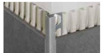
Schlüter-QUADEC est un profilé de finition de haut qualité en acier inoxydable, en aluminium coloré/structuré, en aluminium anodisé, en laiton chromé ou en PVC coloré pour angles muraux sortants et bordures de revêtements carrelés, et assure une protection efficace. La surface visible du profilé forme un angle droit.
