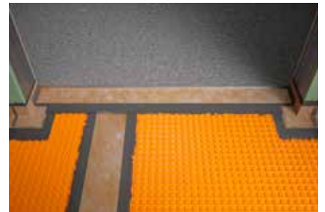
Schlüter-KERDI-CID avec revêtement en pente (6 % max.)
